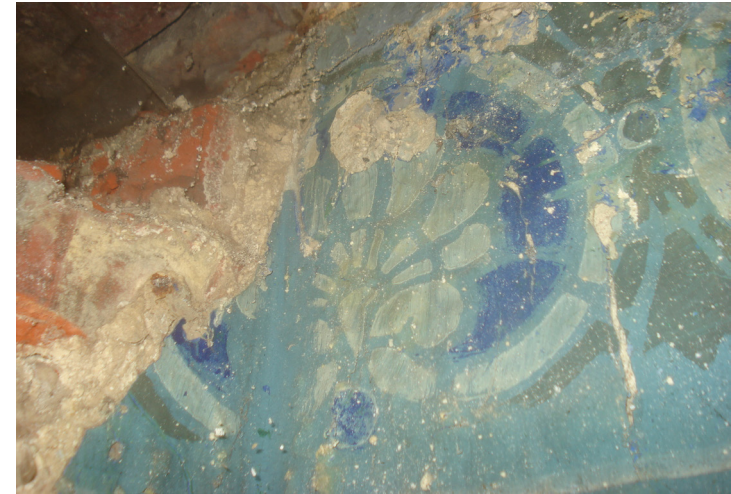
24. Провулок Кравцова, № 13. Напівпідвал, кут південної та східної стіни кімнати. Виразно видно блакитне пофарбування з орнаментальним елементом безпосередньо на первісному тиньку. Світлина В. Романовського, 2019 р. (до стор. 266-278)
